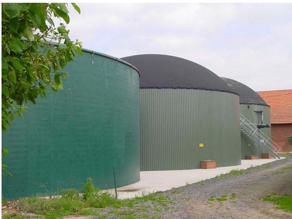
Zbiornik składający i komory fermentacyjne
