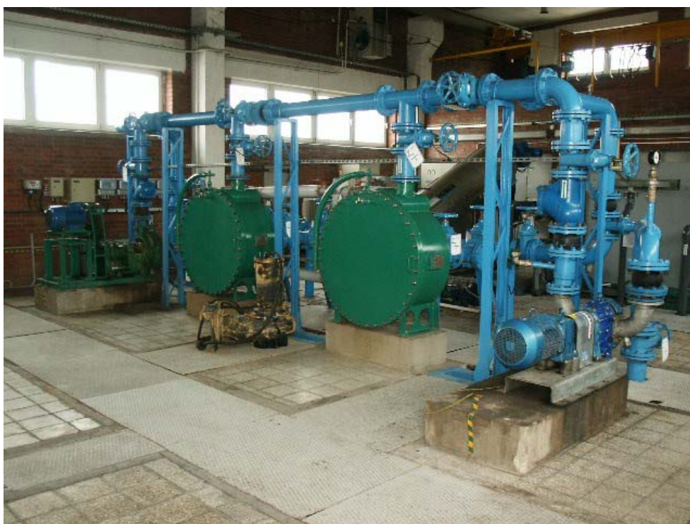
Wymienniki ciepła technologicznego – podgrzew osadów ściekowych
