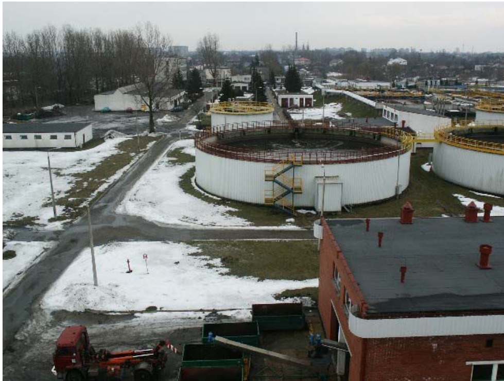
Oczyszczalnia ścieków – część południowo-wschodnia
