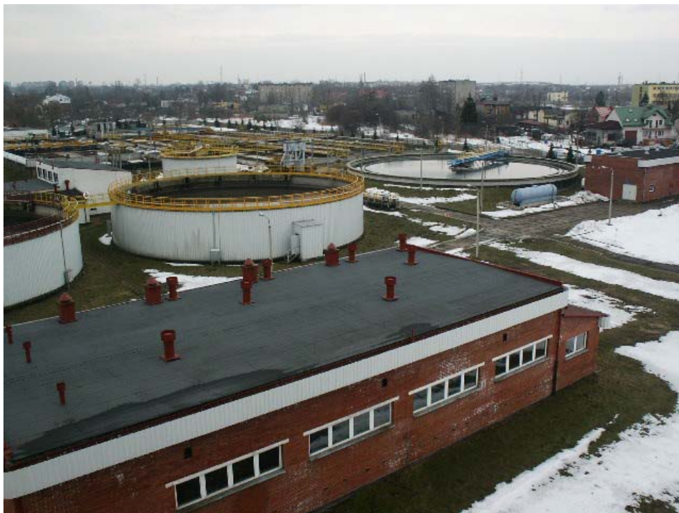
Oczyszczalnia ścieków – część południowo-zachodnia
