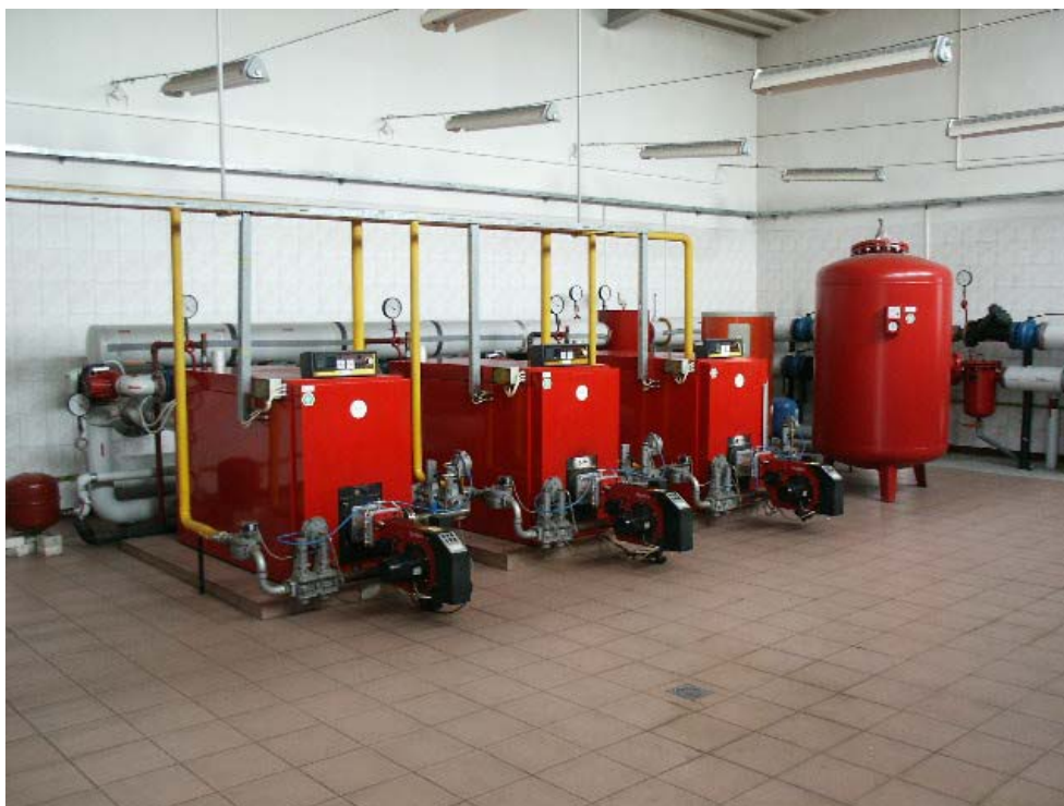
Kotłownia gazowo - biogazowa
