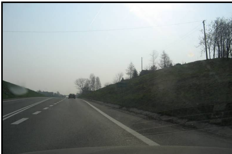
Fot. 1. Wykorzystanie ekranujących właściwości wykopu (droga krajowa nr 4 na odcinku Kraków - Tarnów)
