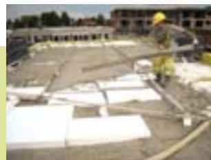
Ocieplenie dachu z przekładą styropianową
