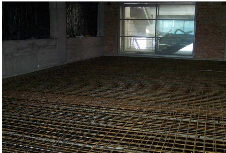
Zbrojenie stropu w sektorze 14 w osiach 141-143/H-K
