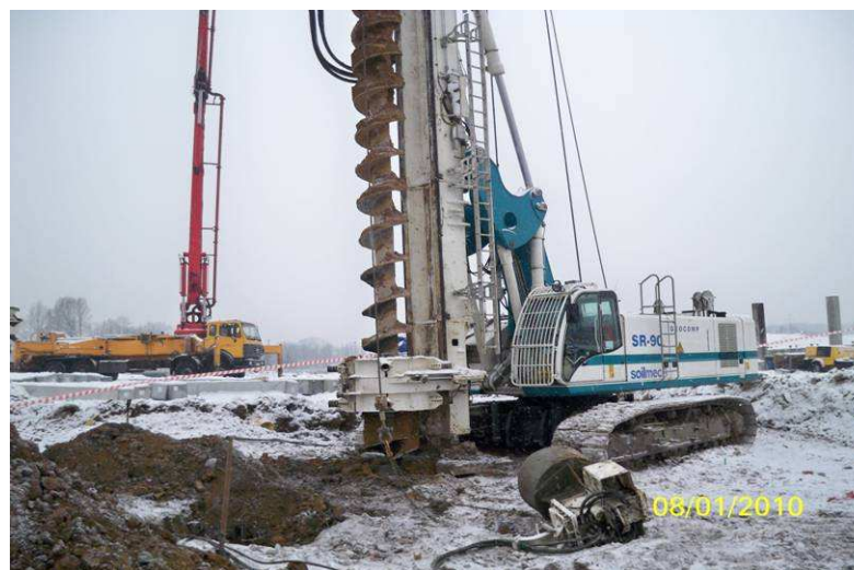
Wykonywanie pali CFA (strona południowo-zachodnia)
