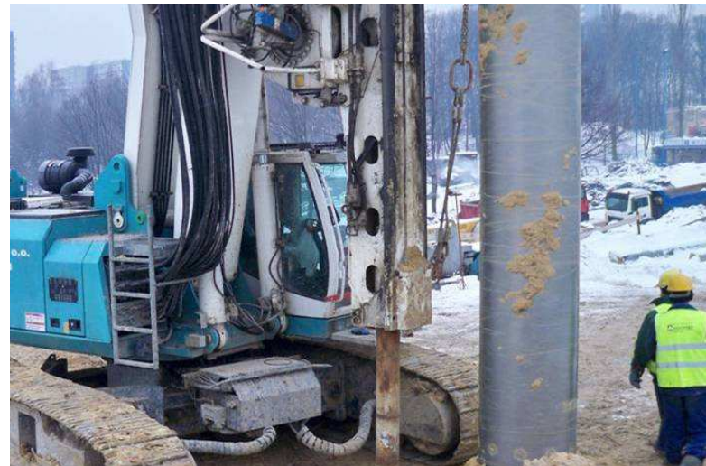
Wykonywanie pali w rurze obsadowej
