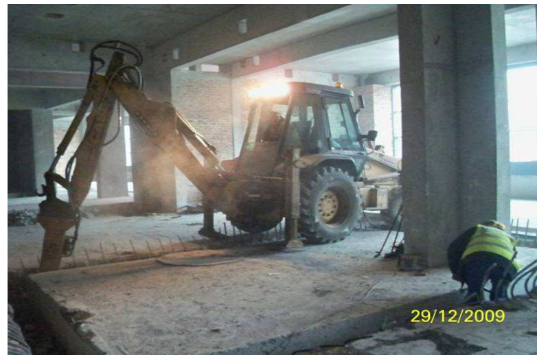
Przygotowanie frontu pod wykonanie palisady w osi X16
