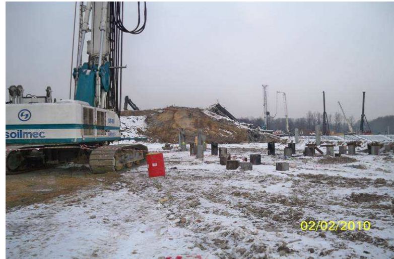
Wykonywanie pali prefabrykowanych
