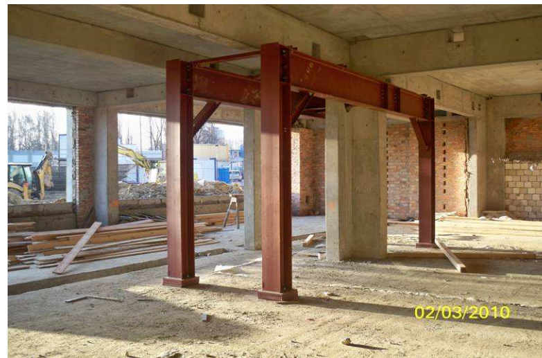
Podparcie istniejącej konstrukcji w osi X16
