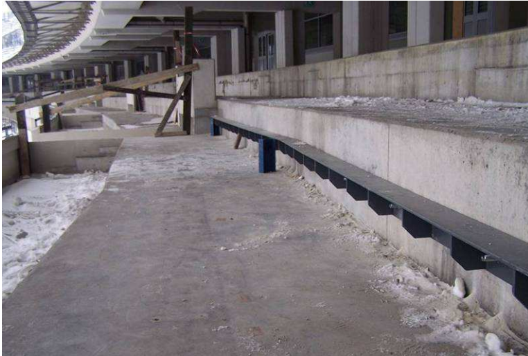
Trybuna wschodnia Konstrukcje wsporcze pod roboty żelbetowe dla VIP-boksów
