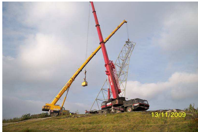
Demontaż wież oświetleniowych od strony zachodniej
