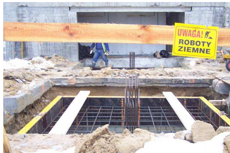
Trybuna wschodnia Stopy fundamentowe pod trybunę w miejscu boksów żużlowych
