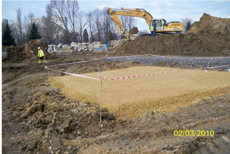
Wykonanie platformy pod montaż żurawi
