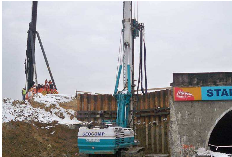
Wykonywanie pali CFA w rejonie wejścia na stadion w osi X21
