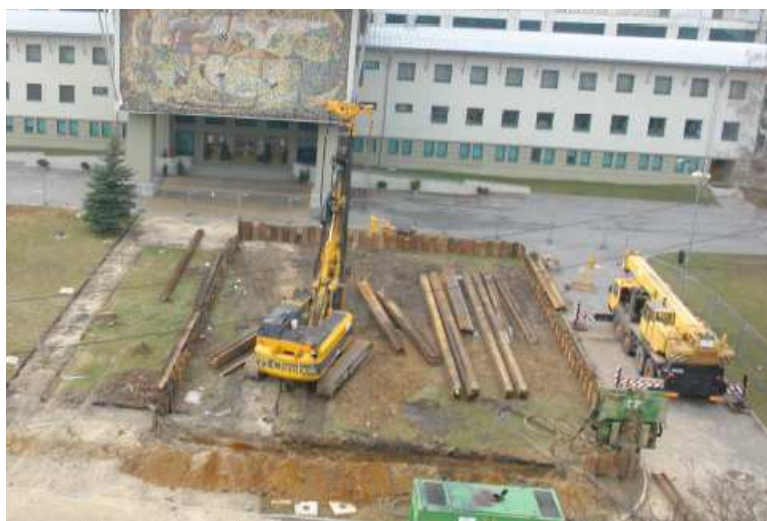
Wykonanie ścianek szczelnych w rejonie zbiornika retencyjnego
