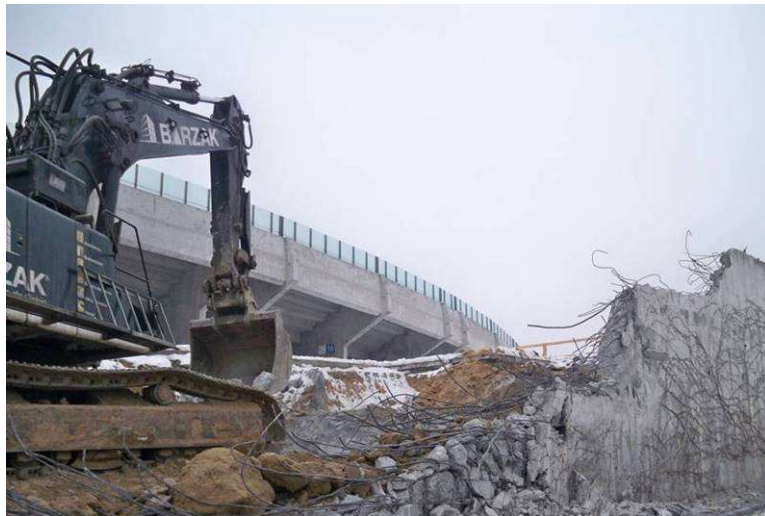
Rozbórka pochylni w osi X04, X17
