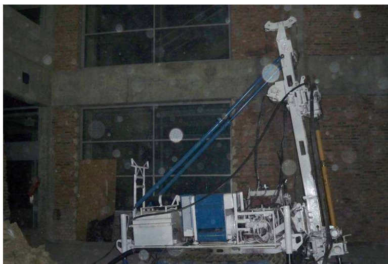
Wykonanie pali Jet-Grouting
