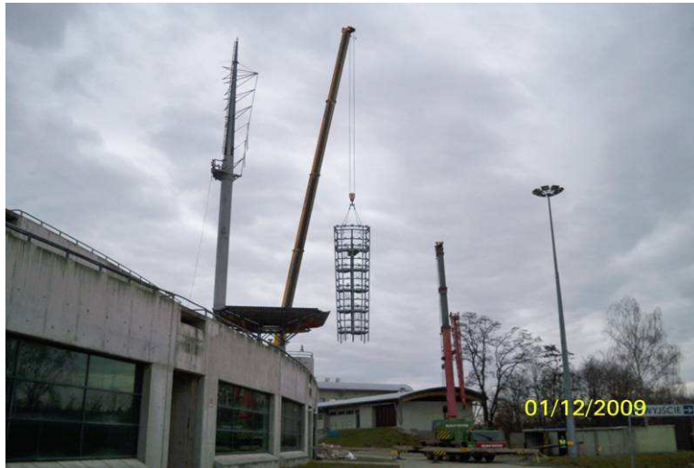
Demontaż wież oświetleniowych od strony wschodniej
