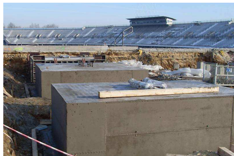
Rozdeskowanie zabetonowanych oczepów trybuny zachodniej
