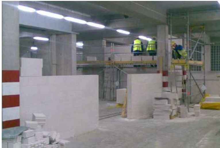
Roboty murarskie na istniejącej trybunie wschodniej
