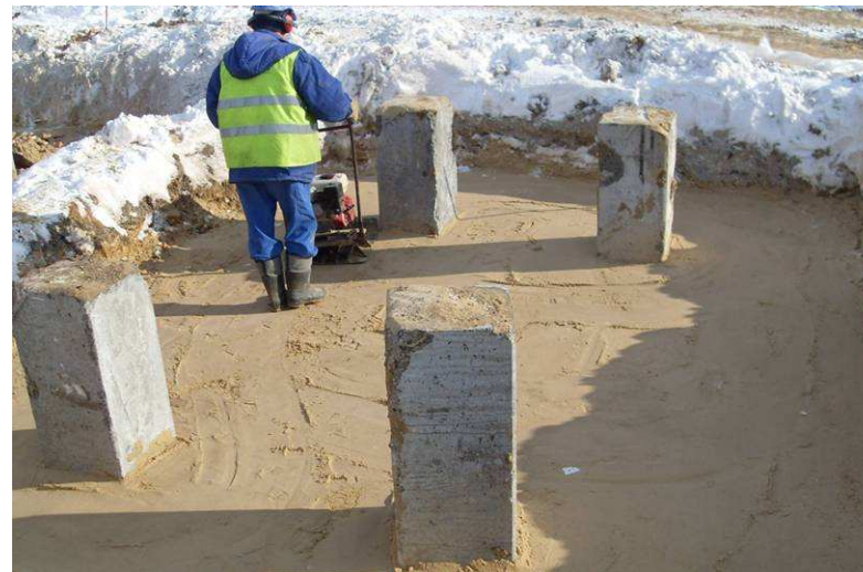
Zagęszczanie podsypki pod chudy beton dla oczepów trybuny zachodniej
