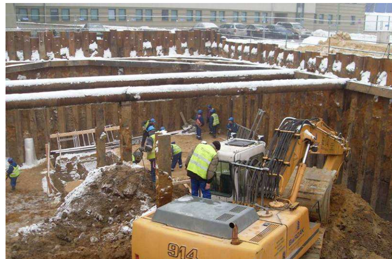
Wykop pod zbiornik retencyjny – kontynuacja robót
