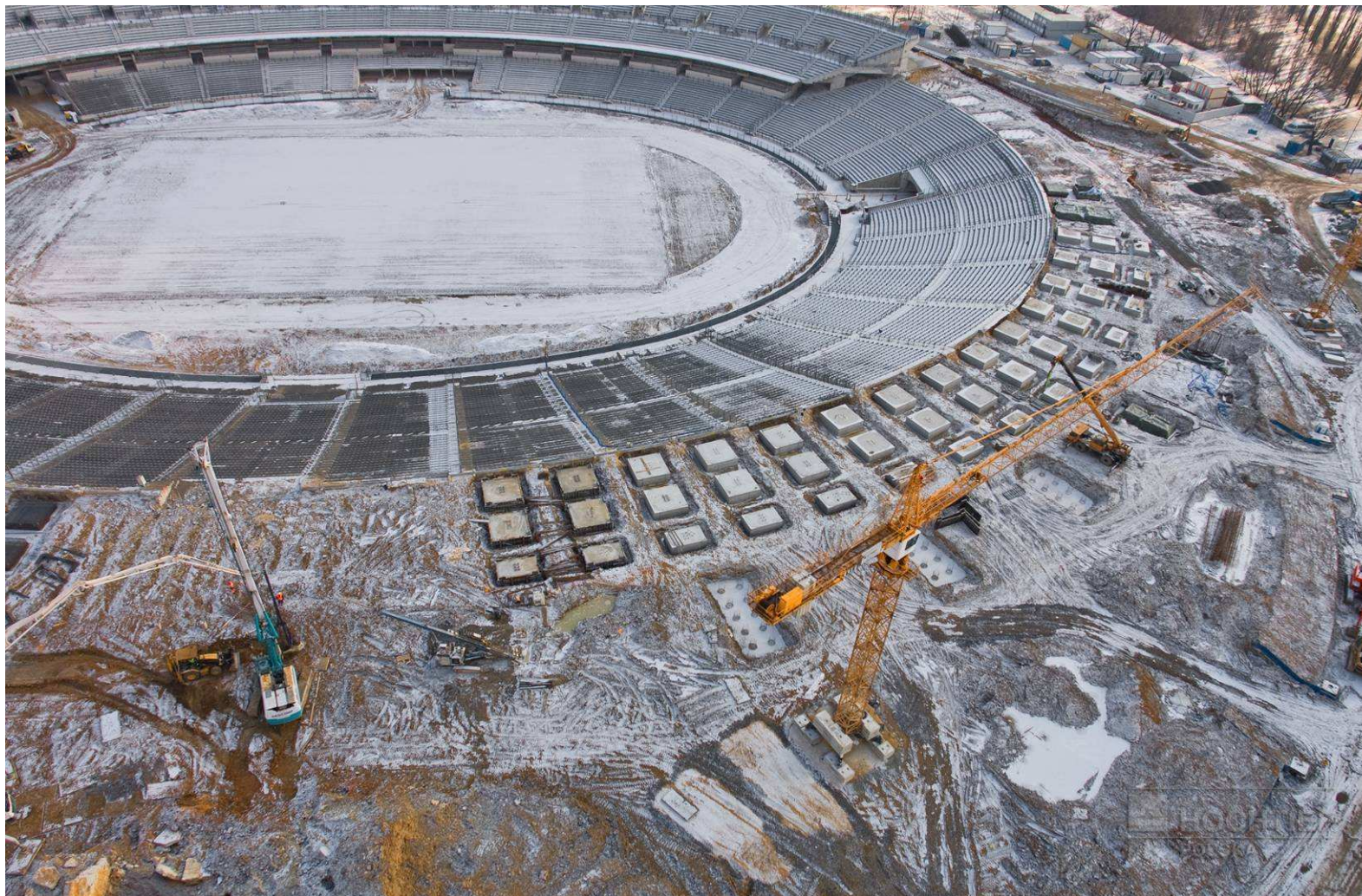
Wykonywanie oczepów oraz stóp fundamentowych
