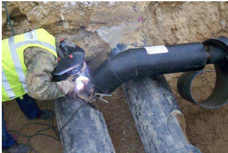
Wykonanie przyłącza sieci ciepłej
