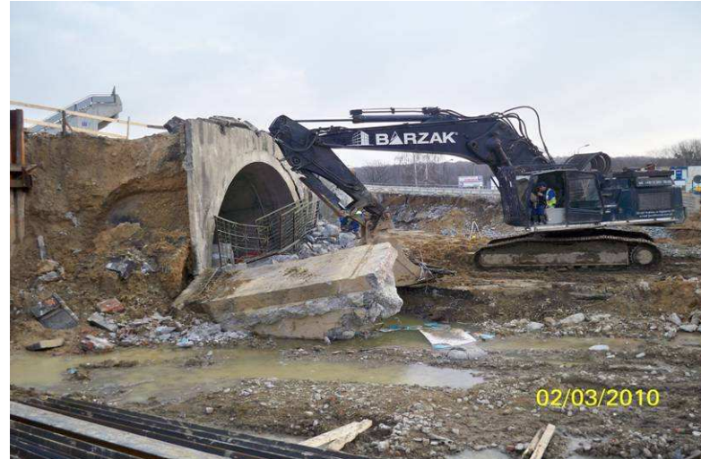
Rozbiórka portali wejściowych do tunelu od strony południowej
