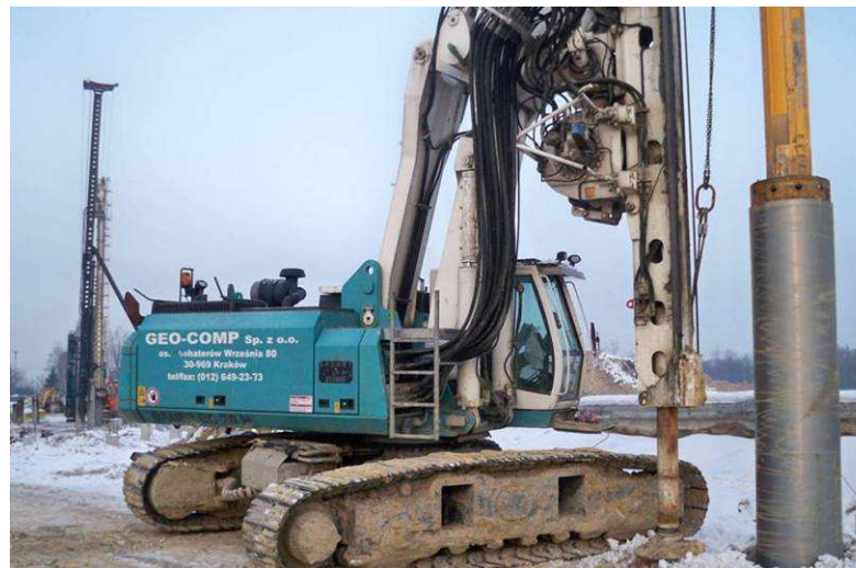
Wykonywanie pali w osłonie rurowej strona południowo - zachodnia przy tunelu
