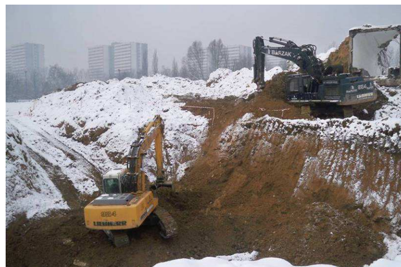
Usuwanie fundamentów wieży telewizyjnej
