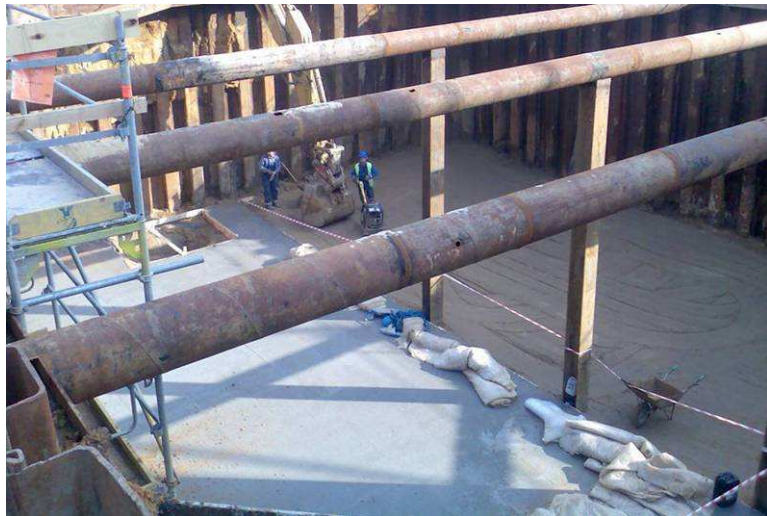
Chudy beton oraz kontynuacja zagęszczanie podsypki pod chudy beton dla płyty zbiornika retencyjnego
