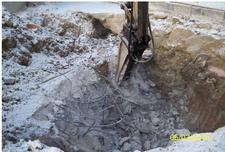
Demontaż istniejącego fundamentu „SATURN” w osi X13
