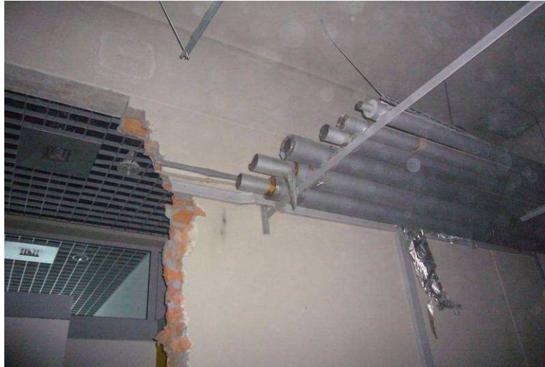
Demontaż instalacji sanitarnych pod prace związane z oczepem garażu oś X06
