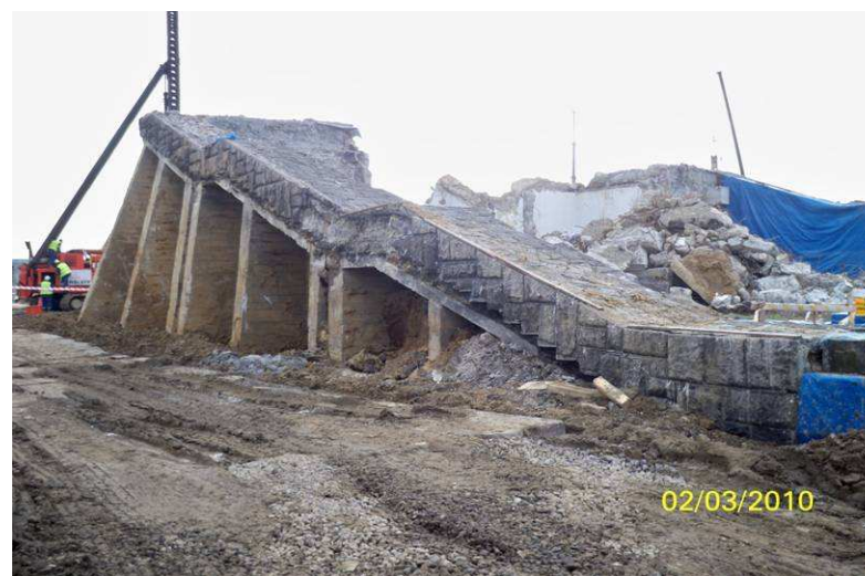
Rozbiórka wejścia do wyburzonej wieży telewizyjnej
