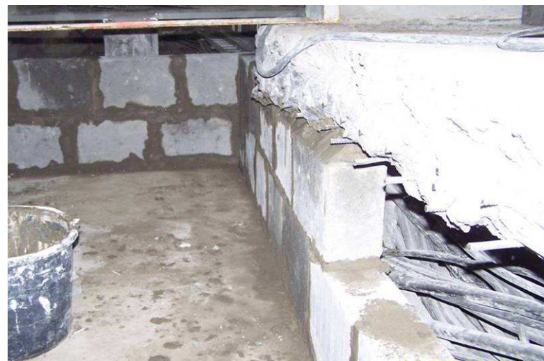
Roboty murarskie w sektorze 14 celem zabezpieczenia stacji trafo podczas robót przy oczepie X14
