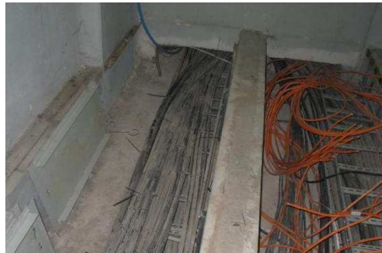
Kontynuacja wyburzeń i rozbiórek na trybunie wschodniej - demontaż kabli elektrycznych
