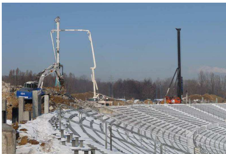
Pale wbijane - roboty prowadzone od strony południowej i północnej na trybunie zachodniej
