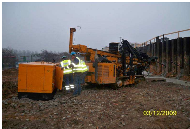
Wykonywanie kotew gruntowych od strony południowo-wschodniej i północno-wschodniej
