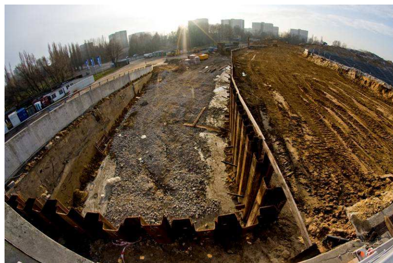
Wykonanie ścianki szczelnej
