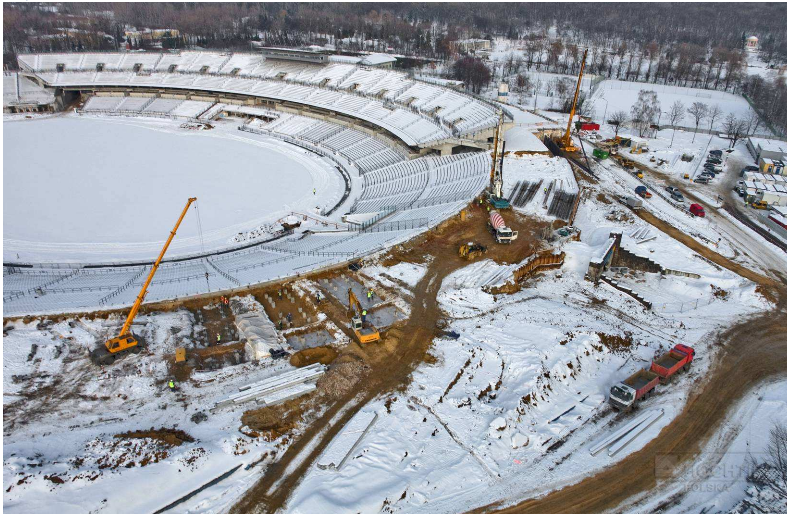
Skuwanie głowic pali, chudy beton pod oczepy oraz stopy fundamentowe
