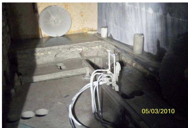
Przygotowanie frontu pod palisadę w osi X10 – Cięcie w płycie dennej
