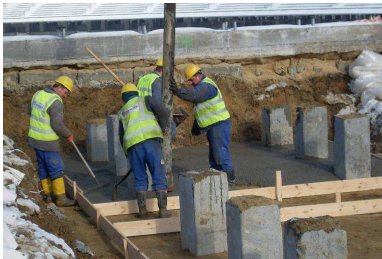
Układanie chudego betonu pod oczepę trybuny zachodniej
