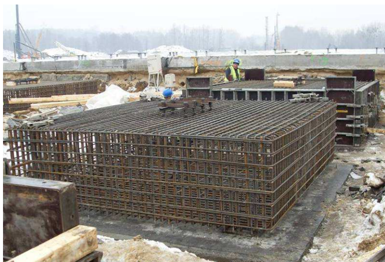
Zbrojenie oraz deskowanie oczepów trybuny zachodniej
