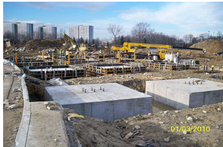
Deskowanie oczepów trybuny zachodniej
