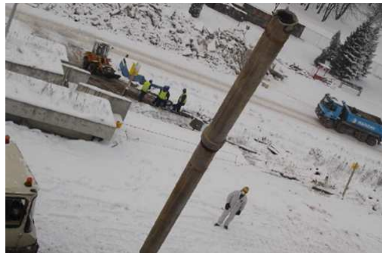
Usuwanie rury azbestowej z wieży telewizyjnej
