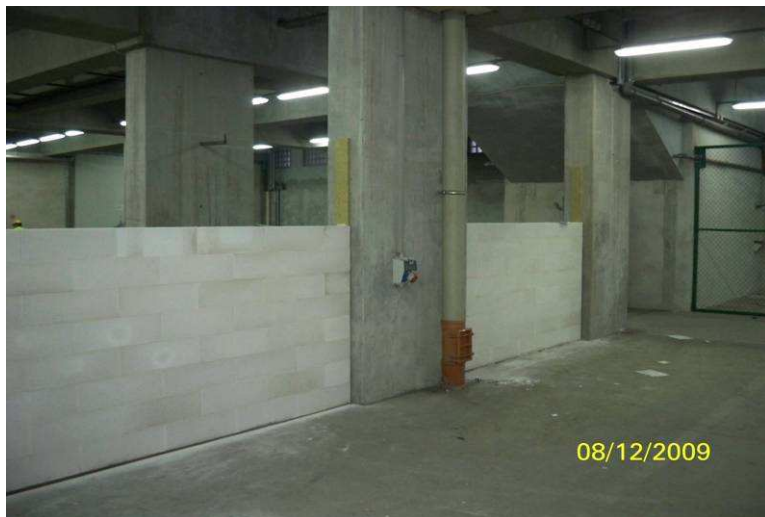
Roboty murowe na trybunie wschodniej w rejonie osi X07
