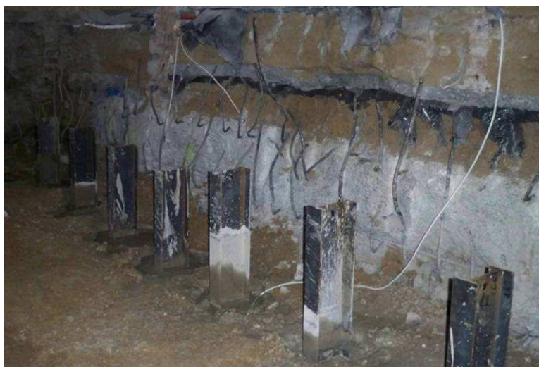
Zabezpieczenie fundamentu w osi X05, X07 (palisada)
