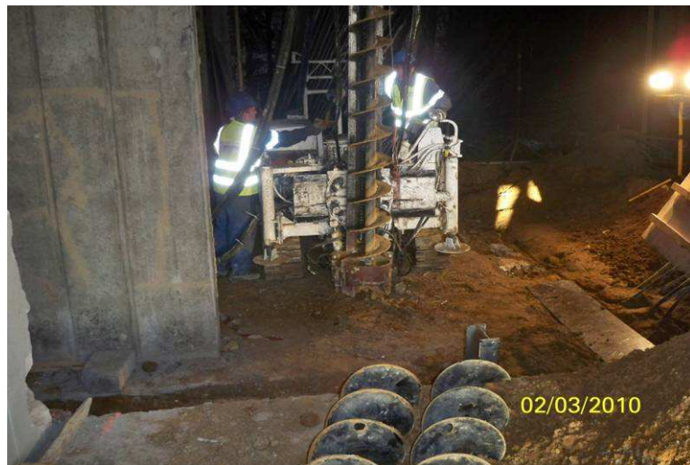
Wykonywanie palisady zabezpieczającej w osi X14
