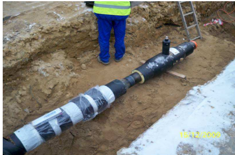
Układanie sieci ciepłej
