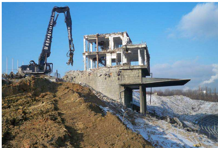
Wyburzanie wieży telewizyjnej na trybunie zachodniej
