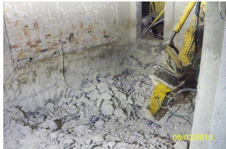
Demontaż istniejącego fundamentu „SATURN” wewnątrz budynku w osi X06
