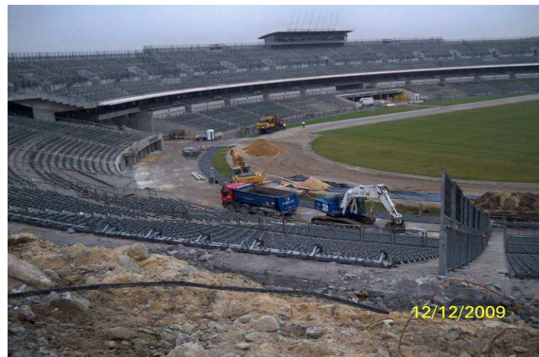
Roboty wyburzeniowe pod wykopy w rejonie boksów żużlowych
